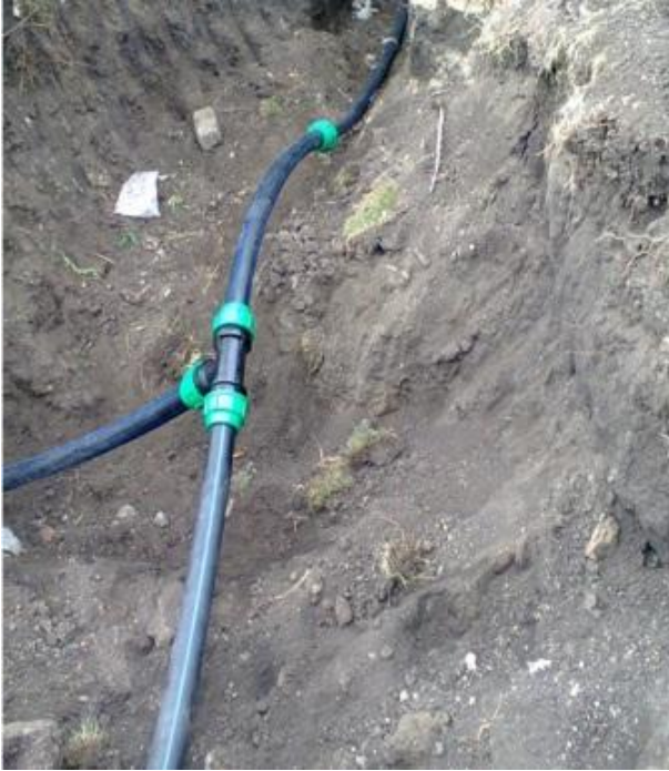
Якісне водопостачання – якісне життя
